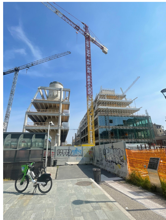
I lavori di costruzione della BEIC nella zona dell'ex Stazione di Porta Vittoria
