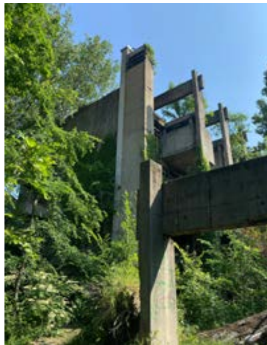
La struttura presenta travi esterne in cemento armato
