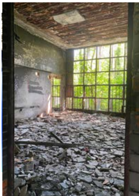
In molti ambienti il soffitto è crollato, riempiendo il pavimento di calcinacci
