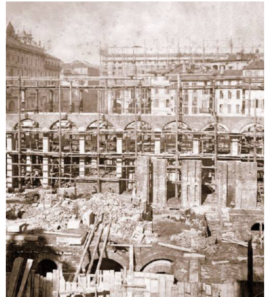
Il Palazzo dei Portici Meridionali in costruzione
