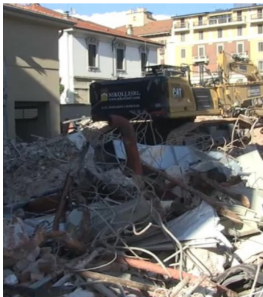
La palazzina Liberty di via Crema demolita
